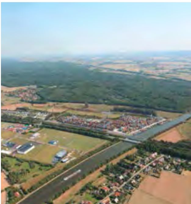
Am Mittellandkanal entsteht ein neuer Container-Umschlagplatz.
