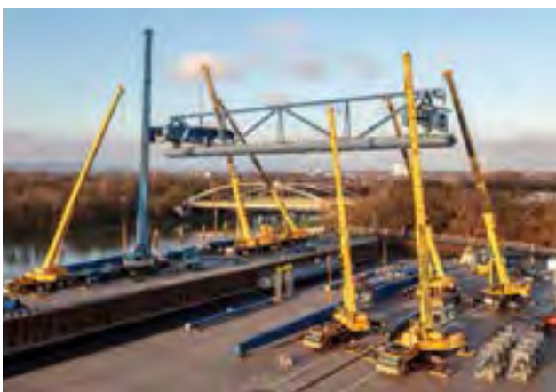
Die erste Krananlage am RegioPort Weser ist bereits montiert.
